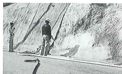
土木現場・モルタル吹付
