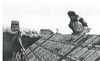
コンクリートの目地つめ
